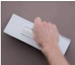
Ripassando la superficie dopo l'essiccazione di RIVELA (5 ore) con il frattone IMPRONTE si può enfatizzare l'effetto estetico e la lucentezza della finitura che dipendono dalla tecnica applicativa e possono essere enfatizzati e personalizzati dall'abilità dell'applicatore.
